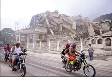
مبنى مدمر بالزلازل في كراكاس
